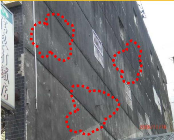
水泥牆表面汙損破損嚴重
